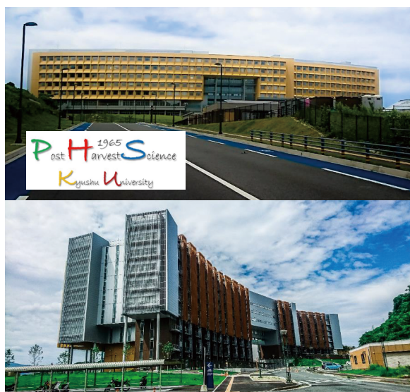
図1 九州大学ウエスト5号館(農学部) (上:南側,下:北側)
